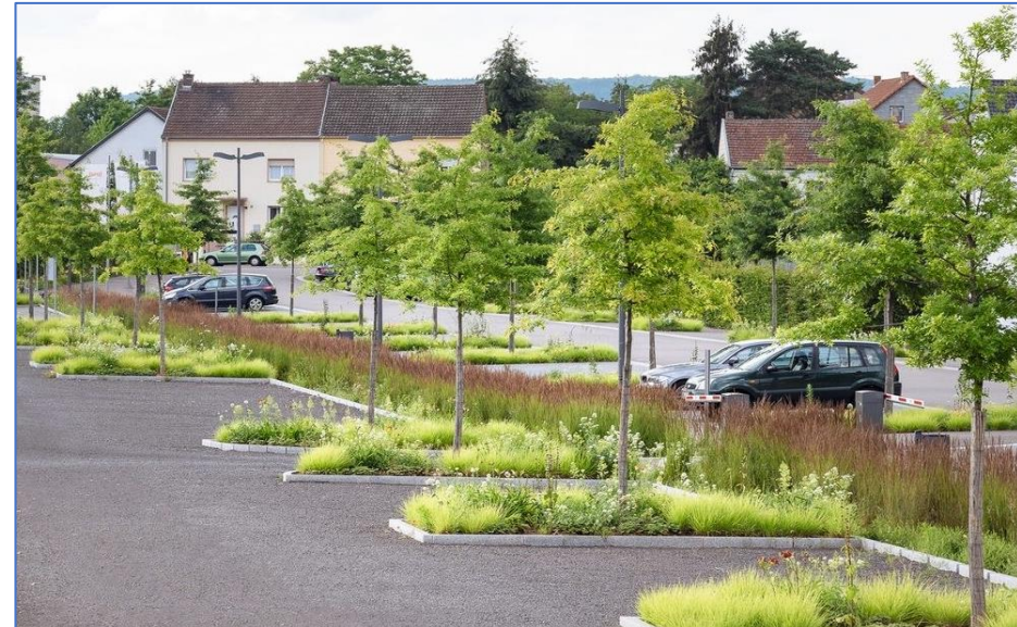
Parkoviště se zásakovými pásy
